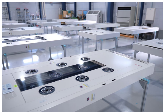
エアーシャワー組立作業
