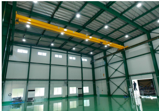
組立工場（大型装置用）
